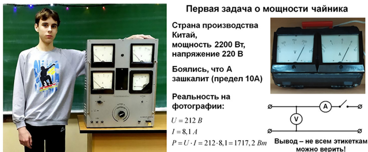
Рис. 1. Старинный щит электропитания и взятые из него два прибора
